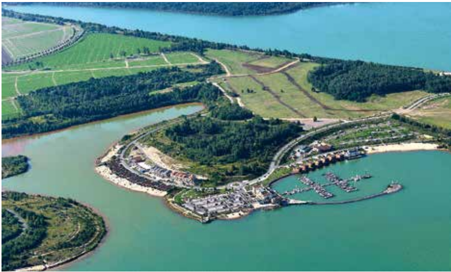
Möglicher Standort für ein neues Helmholtz-Zentrum mit dem Projekt CLAIRE (Centre for Climate Action and Innovation – Research & Engineering) auf der Magdeburger Halbinsel am Störmtalsee, Foto: LMBV
